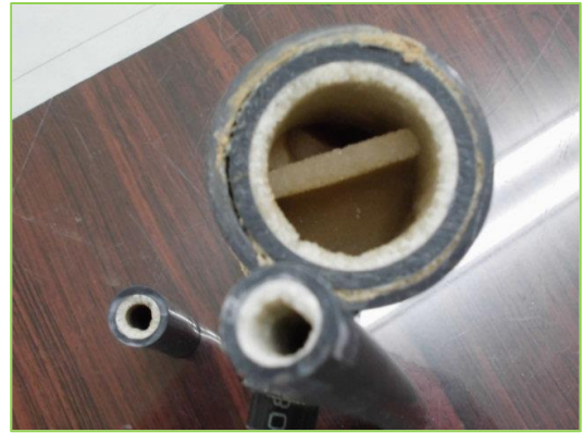
(写真2) 石灰詰まりの配管
