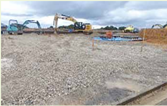
現場の造成状況
