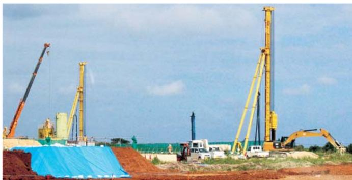
急ピッチで進む沖永良部農業水利事業地下ダム止水壁(5工区)建設工事
