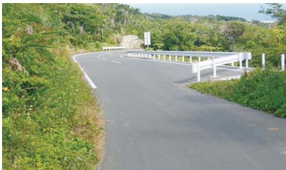
①を反対側から見たところ。約1車線分狭くなっている。
