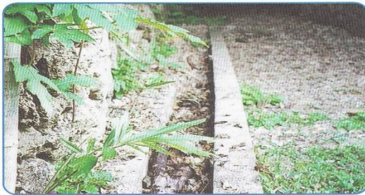
④ 小道のすみのみぞ（用水路）
