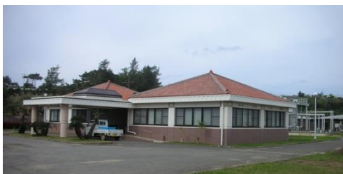
←和泊町浄化センター
