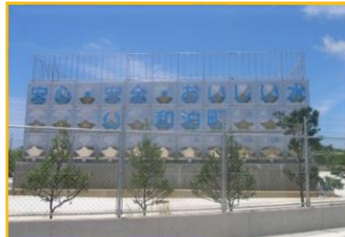
配水池（和泊町和）
