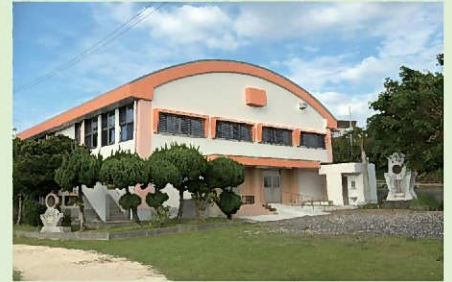
上城小学校屋内運動場改修
