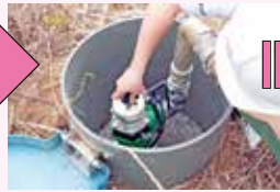
タイマーを回し バルブを上げて散水開始！
