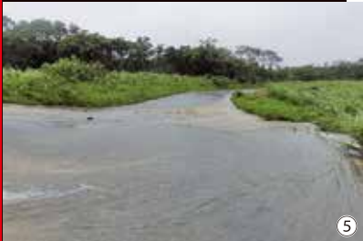
⑤大山林道線（冠水）
