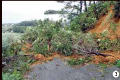
③上城泉川線（土砂崩れ）
