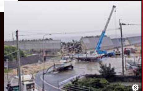
⑧知名漁港（消波ブロック崩壊等）
