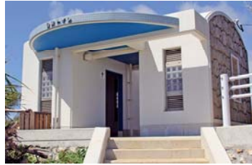
ウジジ浜公園トイレ建設及び園地整備事業 1,641万円
