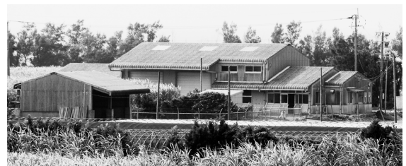
加工機が設置される育苗センター
