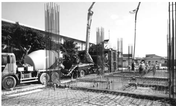
着々と工事が進む知名小学校
