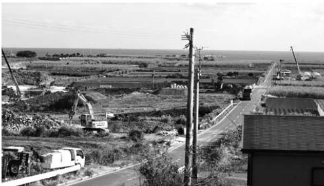
地下ダムの関連工事(余多・屋者地内)
