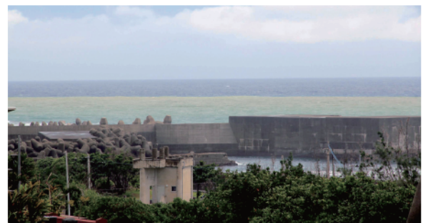
大雨後の小米港沖(10/10)
