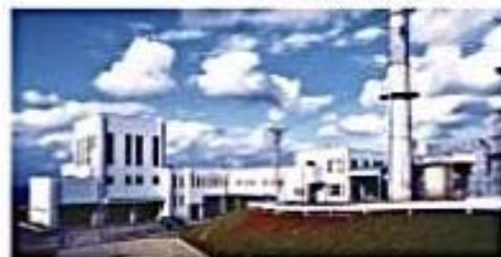
沖永良部クリーンセンター
