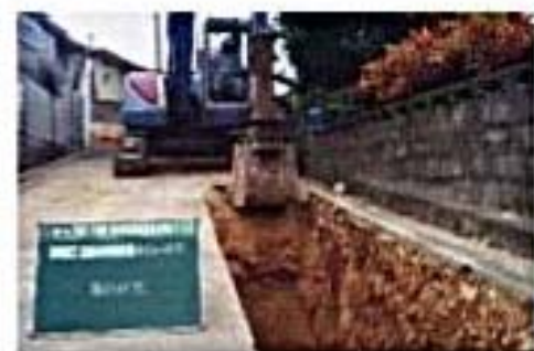
下水道配管工事
