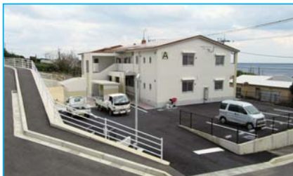
整備が進められる知名C団地A棟
