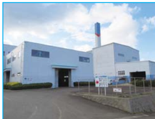
ごみ処理施設(沖永良部クリーンセンター)
