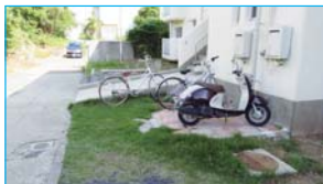
駐輪場整備が望まれる
