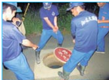
消防水そう点検
