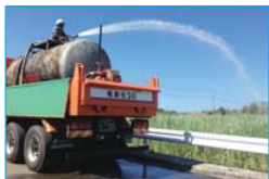
干ばつ対策（散水状況）
