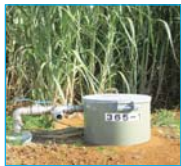
整備が進むかん水施設
