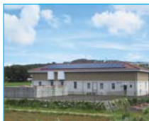
余多揚水機場施設
