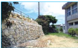
下平川小学校石垣改修
