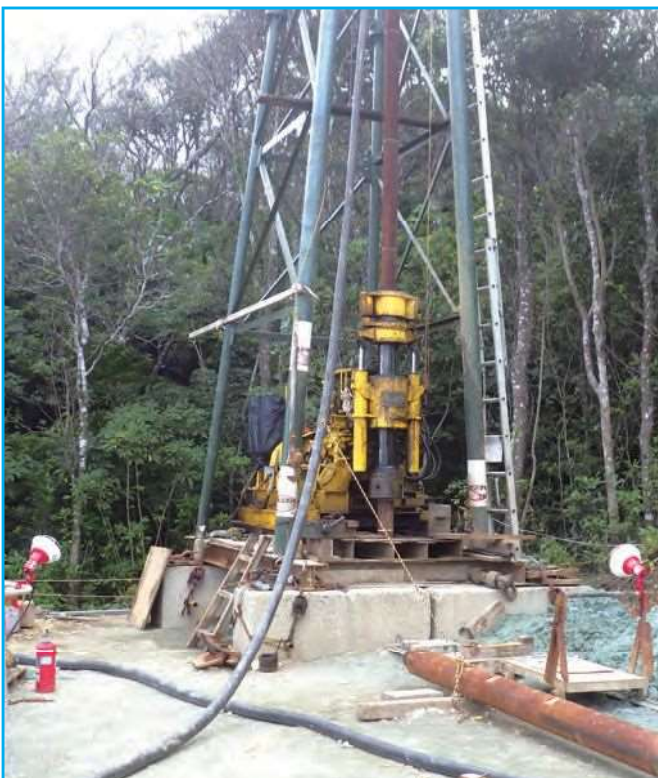
上城第3水源さく井現場
