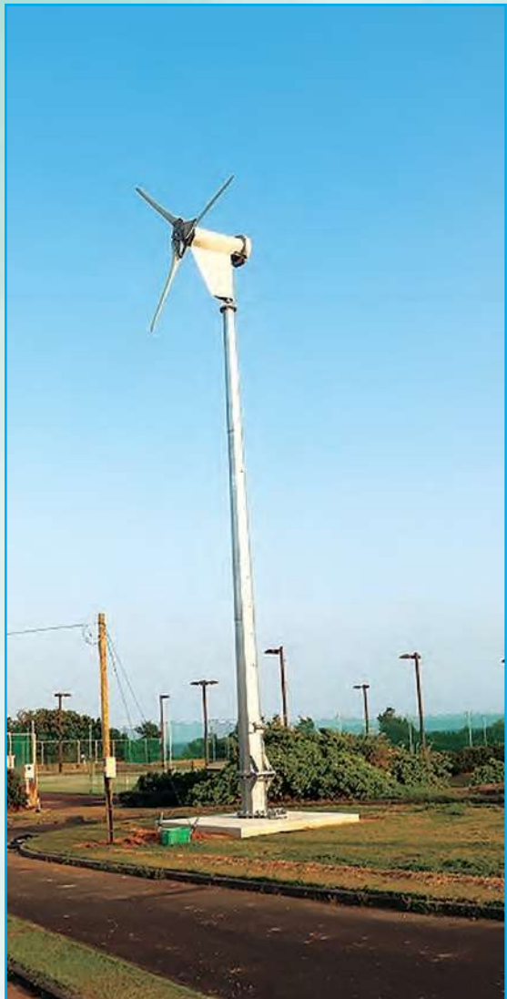
フローラルパークに設置されたダウンウィンド型風車
