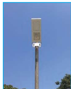
ソーラー街灯LEDの設置
