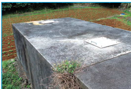
し尿保管タンク
