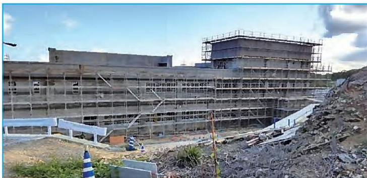
新庁舎建設風景
