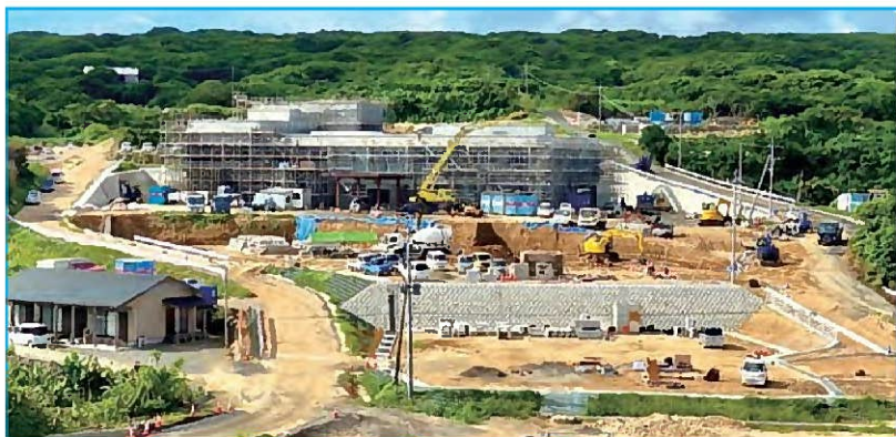
新庁舎建設風景
