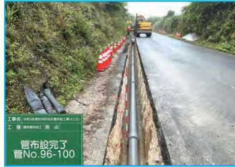
水道施設再編に伴う管布設工事
