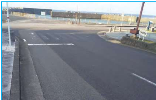
噴水広場横の横断歩道
