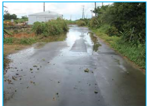
急がれるハチマキ線改良工事
