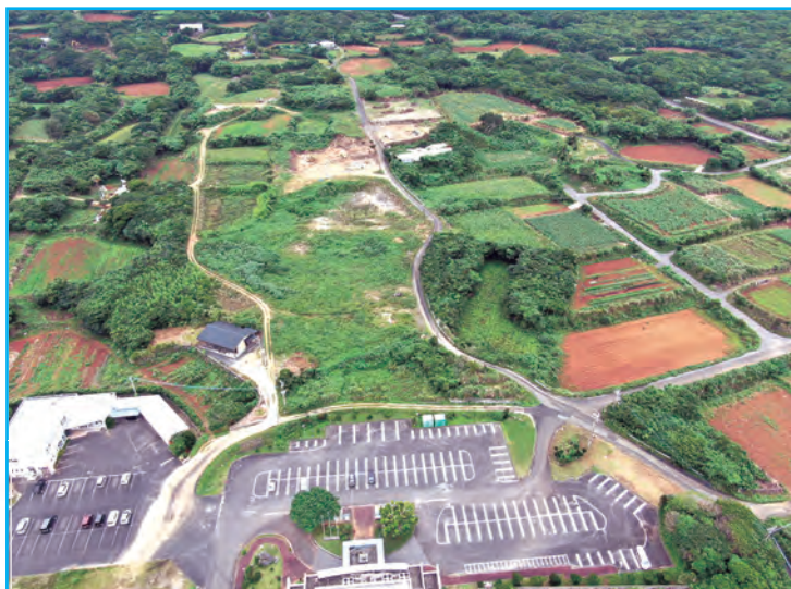
新庁舎建設 造成工事(写真提供 株宗岡組)
