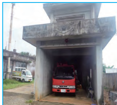
屋子母消防車庫
