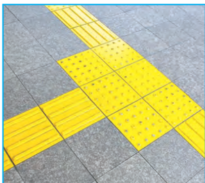
誘導点字ブロックを敷設
