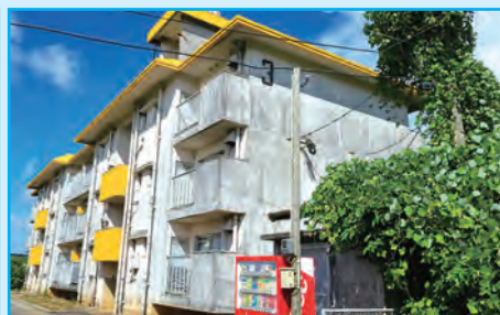
議決した下平川第二団地改修工事
