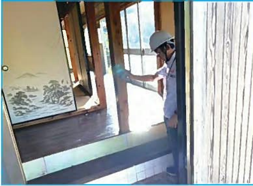
空き家活用事業
