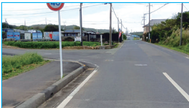
畑かんパイプラインの埋設時に併用舗装を要請
