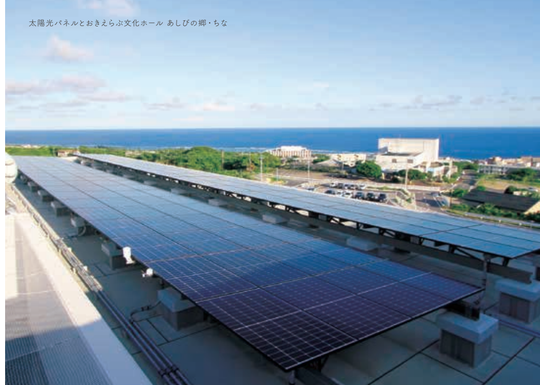
屋上の室外機と塩害対策壁
