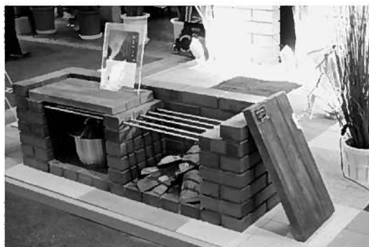
§ 防災ベンチ、非常時はかまど利用
