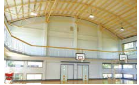
住吉小学校屋内運動場耐震補強改修事業費 8,444万円
