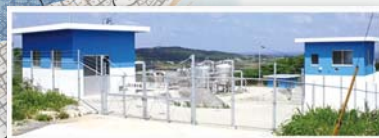
上平川浄配水池
