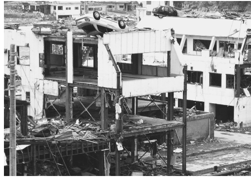
建物の3階部分に打ち上げられた車
