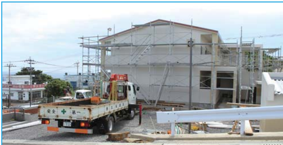
完成間近の知名C団地B棟
