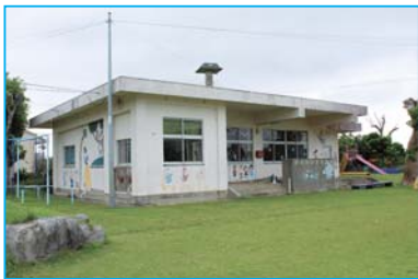
旧上城幼稚園園舎
