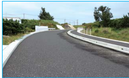
正名地区の県道整備
