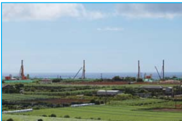
国営地下ダム工事
