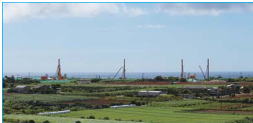
国営地下ダム工事
