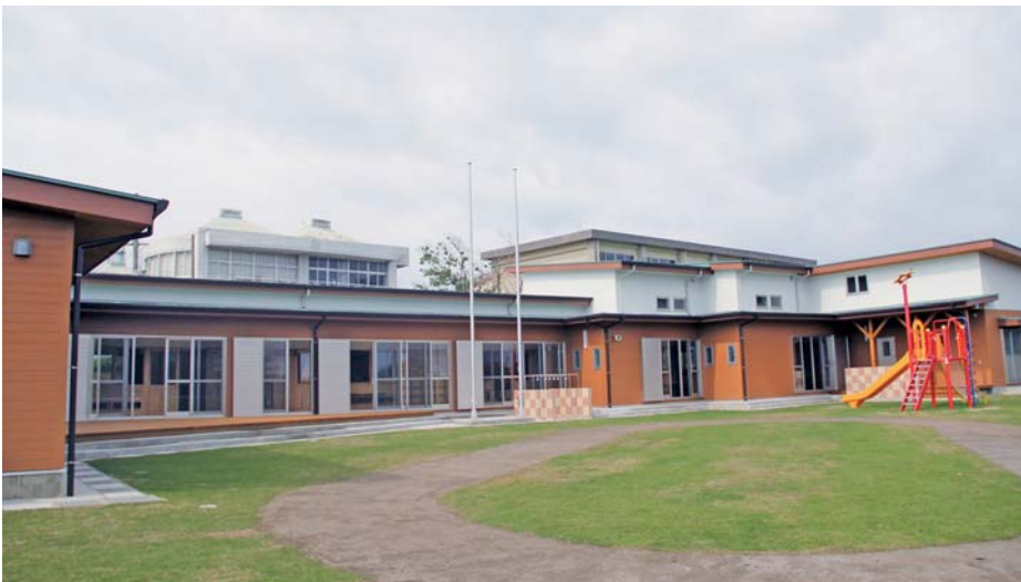
田皆保育所と田皆幼稚園が一体となった認定こども園「きらきら」
