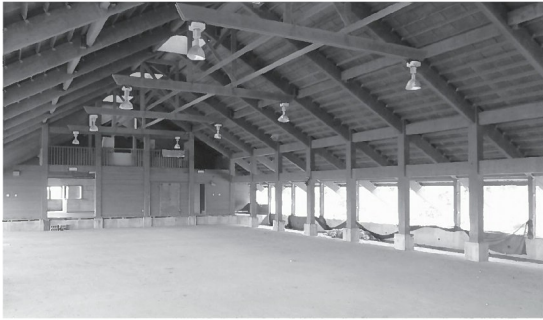
多目的利用が期待される武道館跡地
