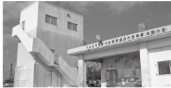
現在稼働中の製水施設
