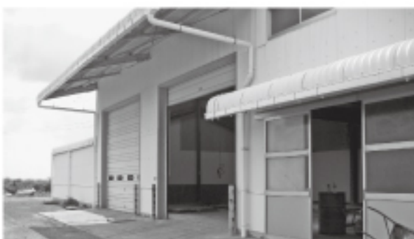
えらぶ特産品加工場建設予定地（町育苗センター）
