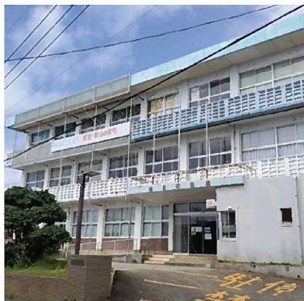
早急な利活用計画が望まれる旧役場庁舎
