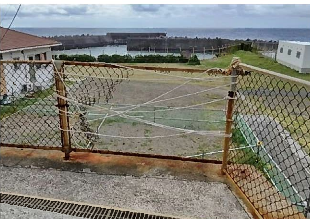
小米防災センターフェンス
